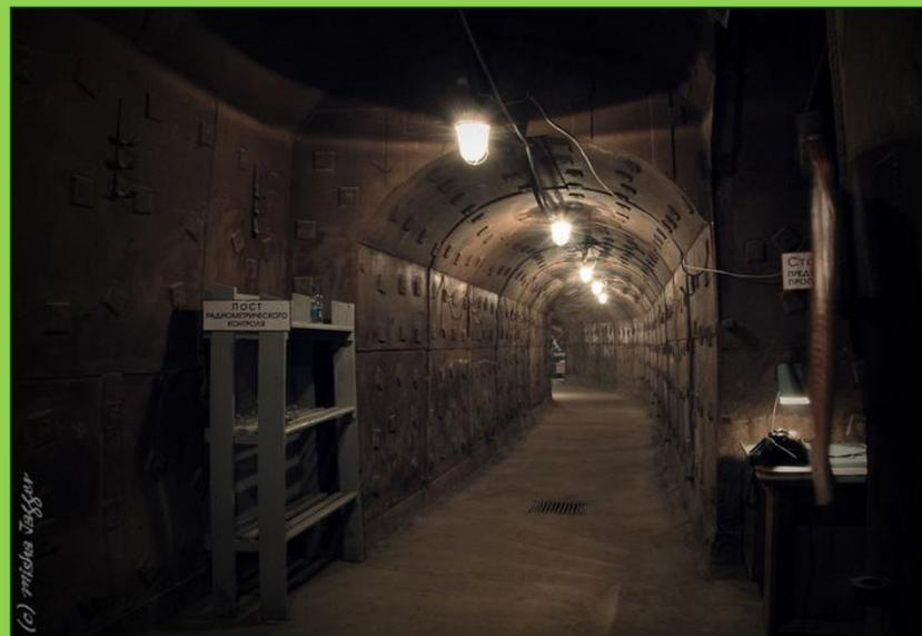
В качестве материалов для убежищ полевого типа применяются стандартные блоки, а также железобетон и металлические кольца. Вход должен иметь два тамбура с защитными и герметическими дверями. Основное помещение оборудуется нарами или скамейками для сидения, отопительными приборами и фильтро-вентиляционной установкой.
