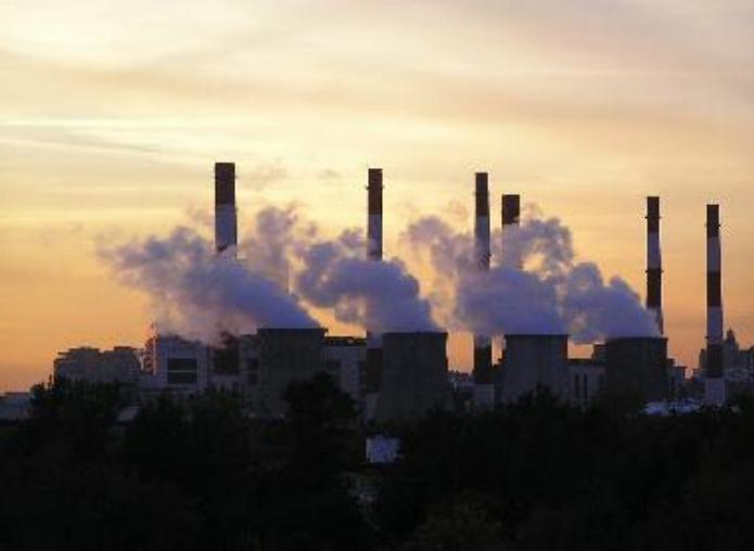
ТЕПЛОВЫЕ ЭЛЕКТРОСТАНЦИИ ПРЕВРАЩАЮТ В ЭЛЕКТРОЭНЕРГИЮ НЕ БОЛЕЕ **40 %** ЭНЕРГИИ, ПОЛУЧАЕМОЙ ПРИ СГОРАНИИ НЕФТИ, ГАЗА ИЛИ УГЛЯ. А ОСТАВШИЕСЯ **60 %** ЭНЕРГИИ ВЫБРАСЫВАЮТСЯ В ОКРУЖАЮЩУЮ СРЕДУ В ВИДЕ ТЕПЛА.
