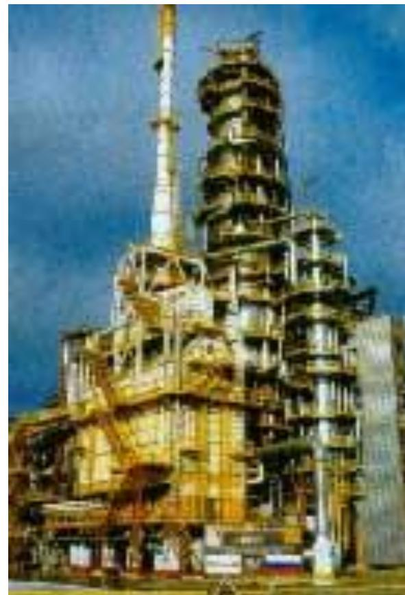
Рис. 4. Установка вакуумной перегонки мощностью 1,6 млн. тонн в год на НПЗ "ЛУКОЙЛ-ПНОС". На переднем плане - трубчатая печь (жёлтого цвета).
