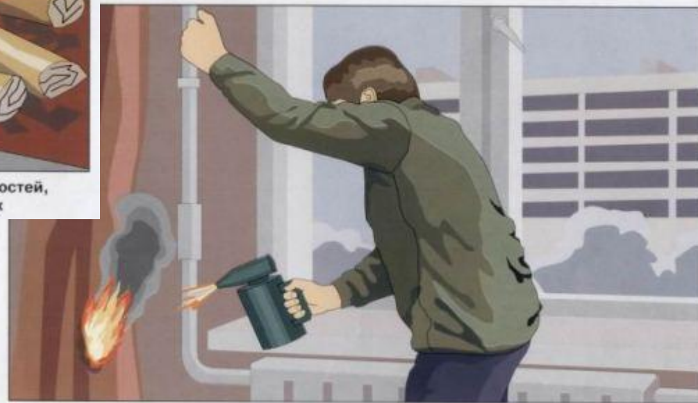
Отогревание замёрзших труб паяльными лампами и факелами
