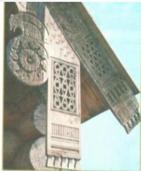
Резные причелина и полотноце избы, жёлоб (водосток). XIX в.
