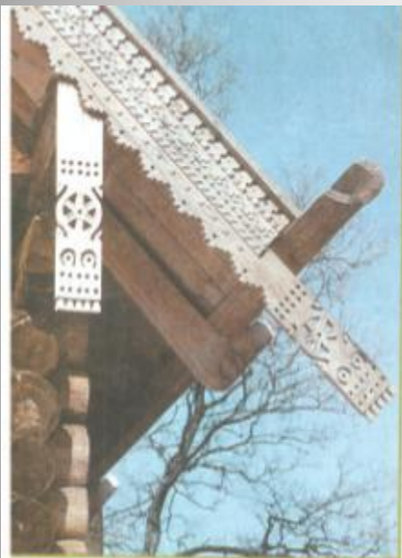
Резные причелина и полотноце избы, жёлоб (водосток). XIX в.
