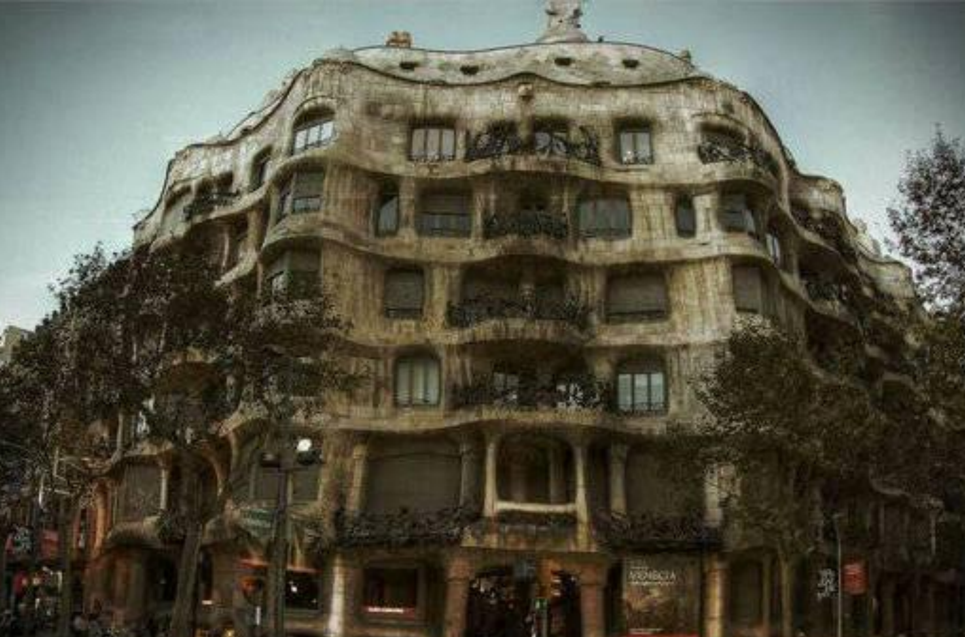
Casa milà или la pedrera - «каменная пещера», Барселона Испания
