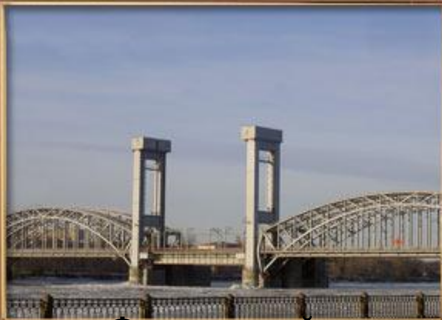
Финляндский железнодорожный мост
