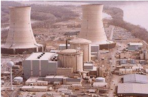
O centrală electrică
