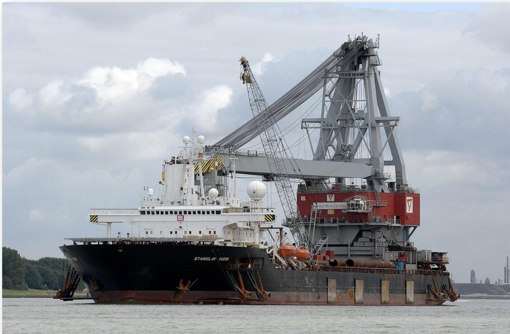
Крановое судно грузоподъёмностью 2500 тонн.
