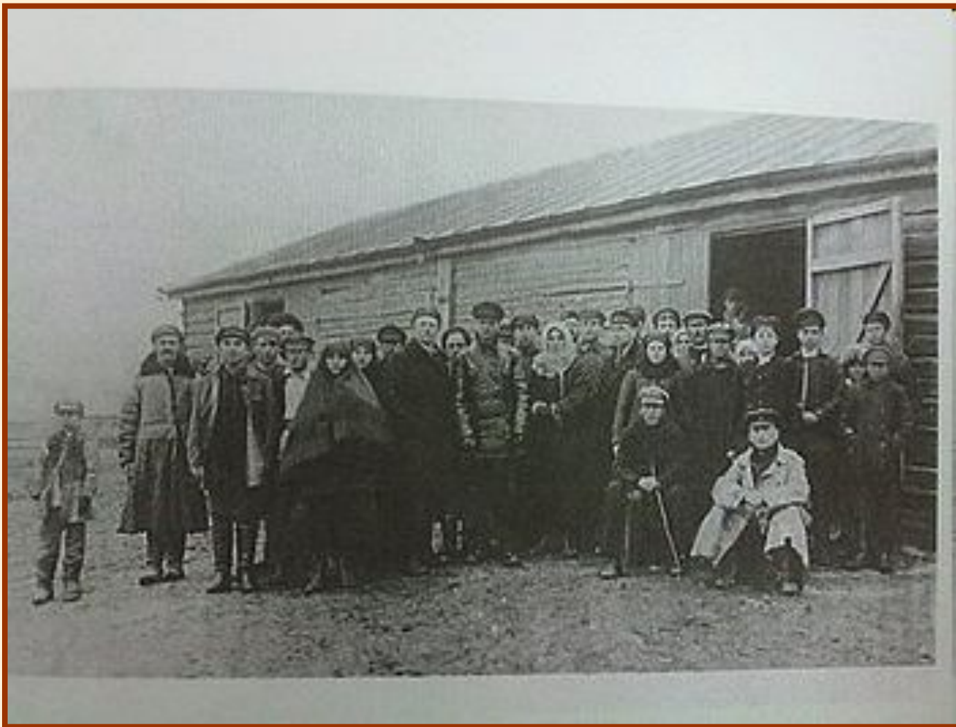
22-летний Андрей Платонов, как ведущий инженер (в центре). Открытие электрической станции в совхозе «Рогачёвка»
