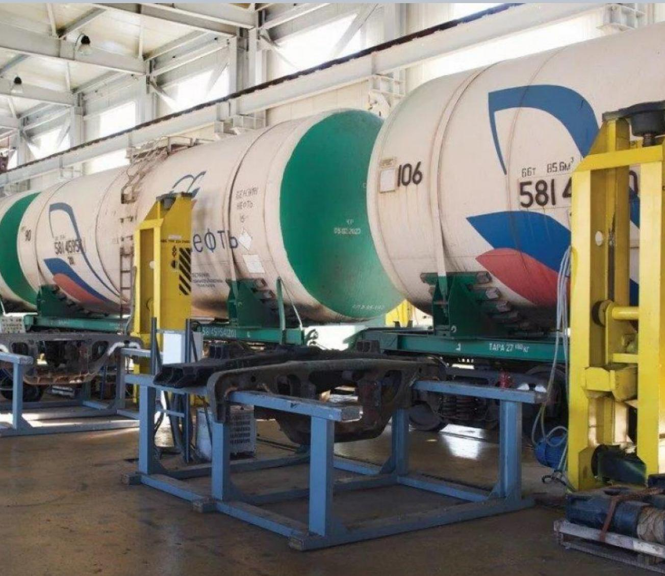
После обмывки и очистки вагон поступает на разборку, предшествующую ремонту. В процессе разборки вагон последовательно расчленяется на составные части, узлы и детали. Разборка производится на специально отведенных и приспособленных для этого местах.
