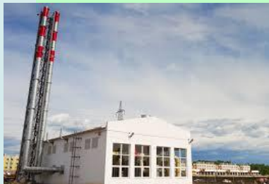
Источник тепловой энергии
