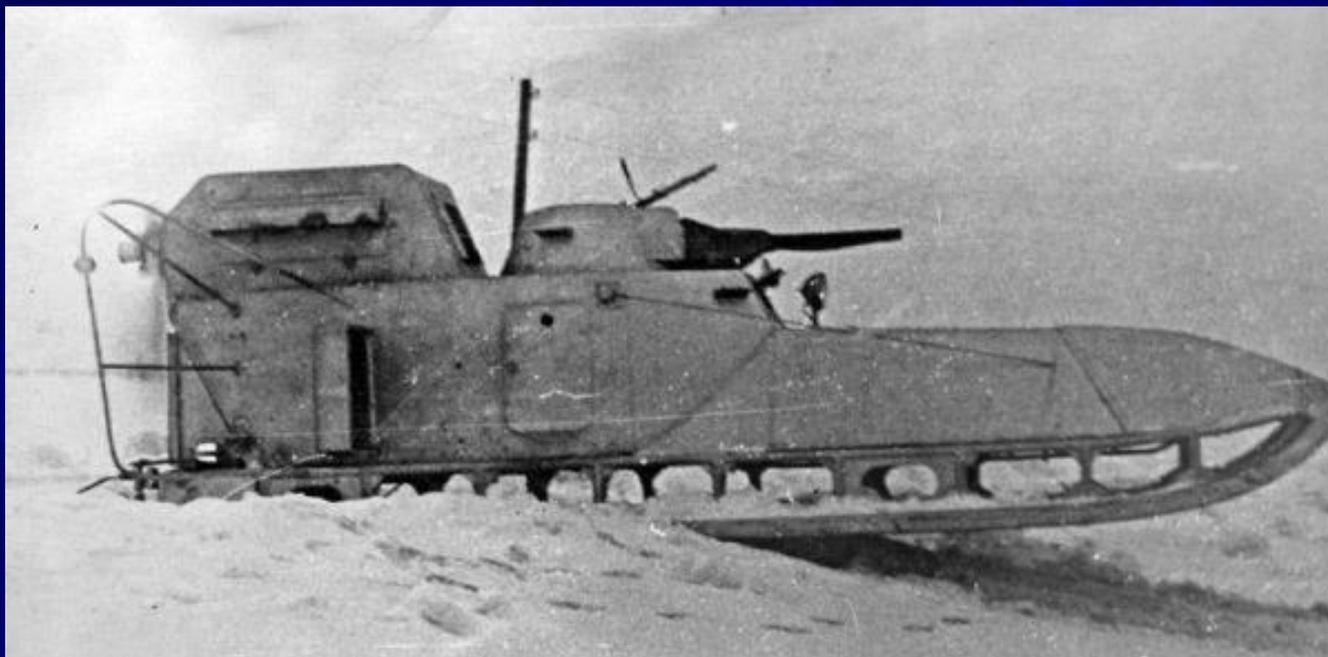
Имели мощное бронирование и вооружение, в отличие от других типов аэросаней, пушечно-пулеметное: на аэросани монтировалась башня танка Т-60 с 23-мм пушкой. В серийное производство запущены не были из-за малой скорости и низкой маневренности связанной с избыточной массой.
