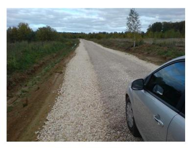
Внешний вид дорожного покрытия основной дороги и кюветов (прямой участок), после устройства верхнего слоя из щебня, расклиненного гравийной смесью.
