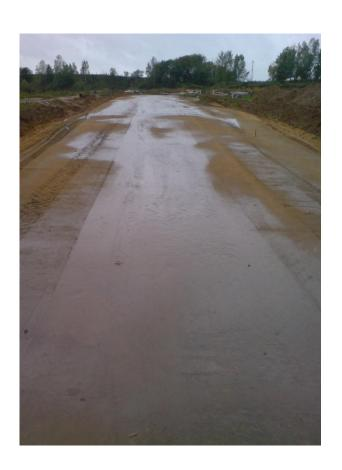
Внешний вид нижнего слоя дорожного покрытия основной дороги (местный грунт, укрепленный 6% цемента и 0.02% стабилизатора типа «LBS»)
