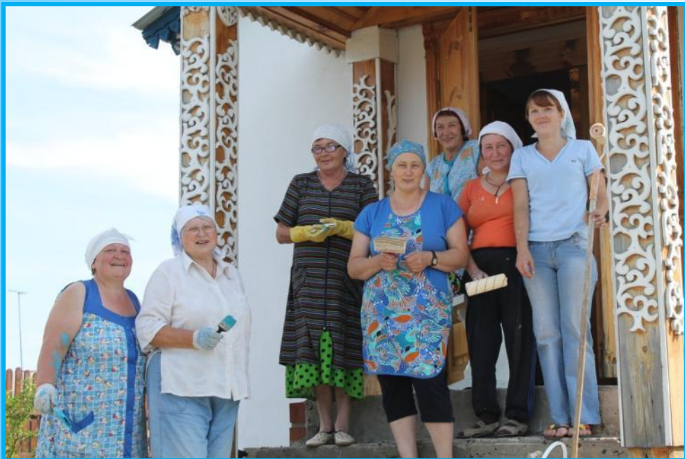
Ремонт храма, лето 2013 года
