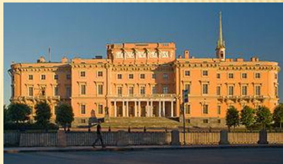
Северный фасад (вид со стороны Летнего сада)
