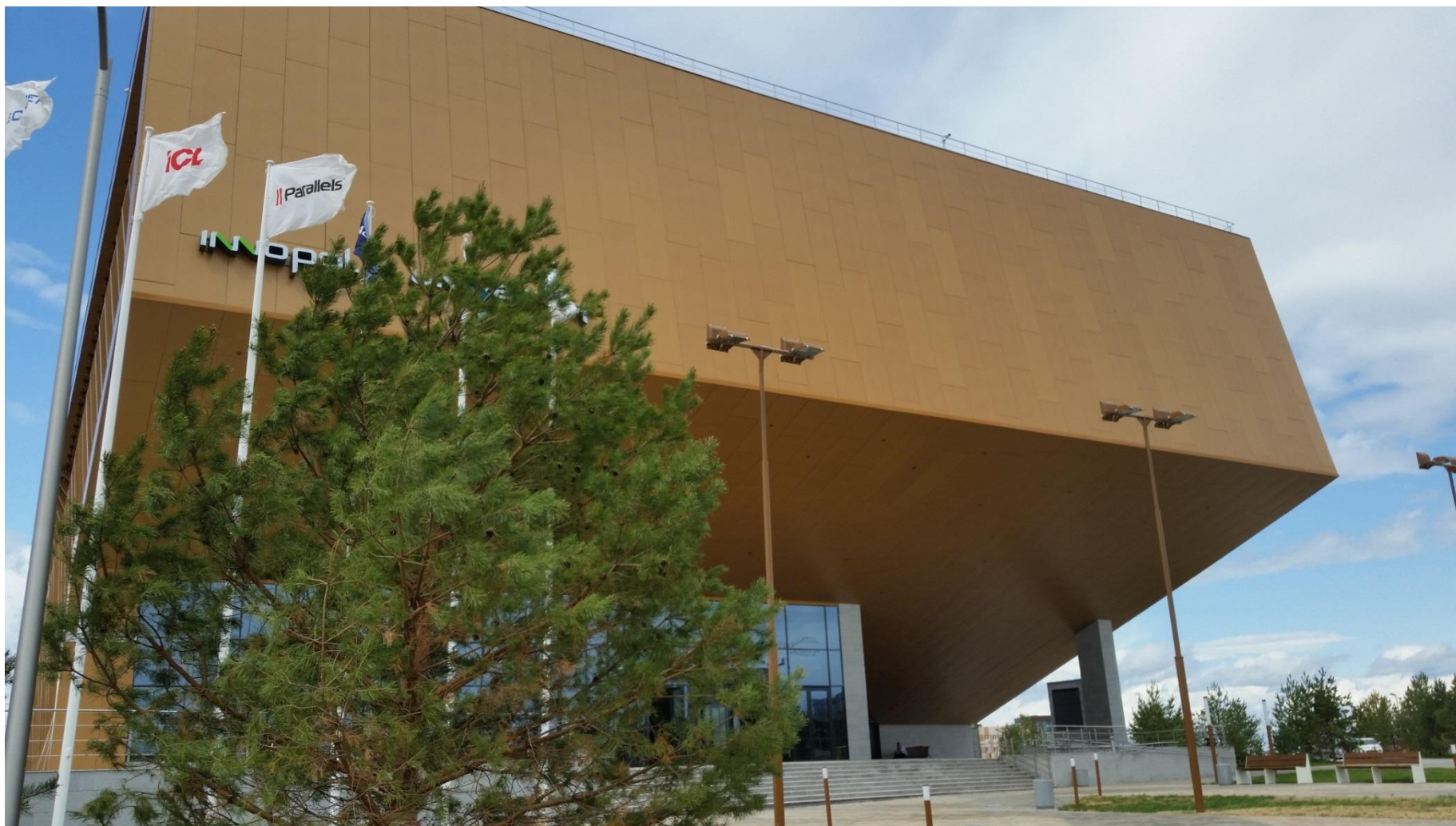
Вид на консольную часть здания университета
