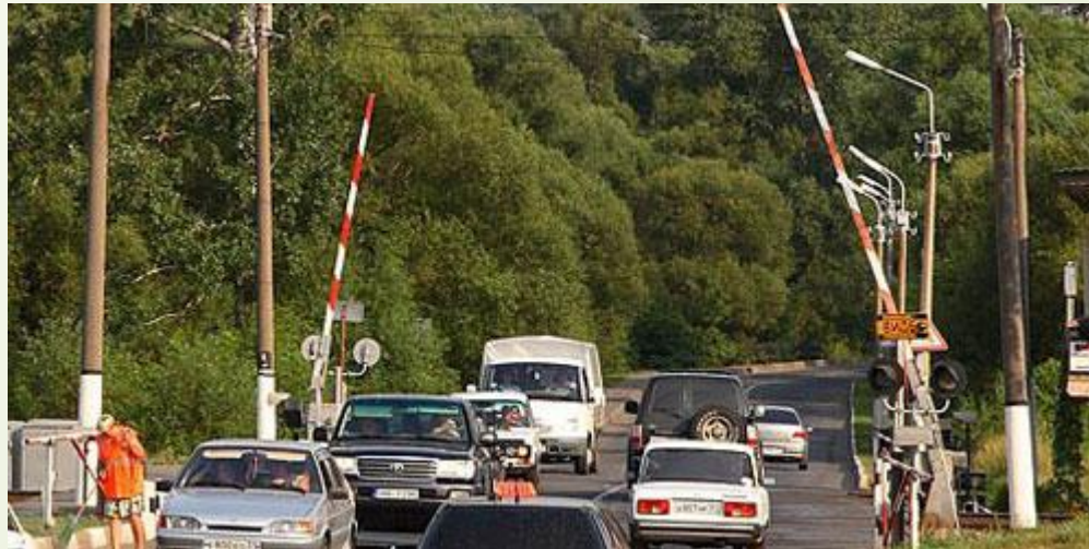
Железнодорожный переезд со шлагбаумом
