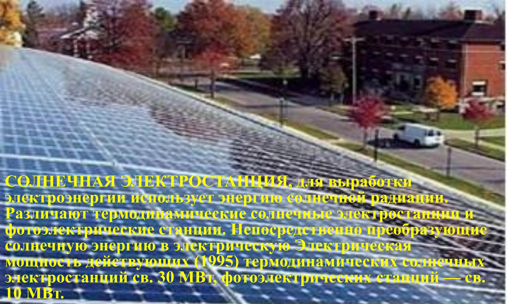
**СОЛНЕЧНАЯ ЭЛЕКТРОСТАНЦИЯ**, для выработки электроэнергии использует энергию солнечной радиации. Различают термодинамические солнечные электростанции и фотоэлектрические станции. Непосредственно преобразующие солнечную энергию в электрическую Электрическая мощность действующих (1995) термодинамических солнечных электростанций св. 30 МВт, фотоэлектрических станций — св. 10 МВт.
