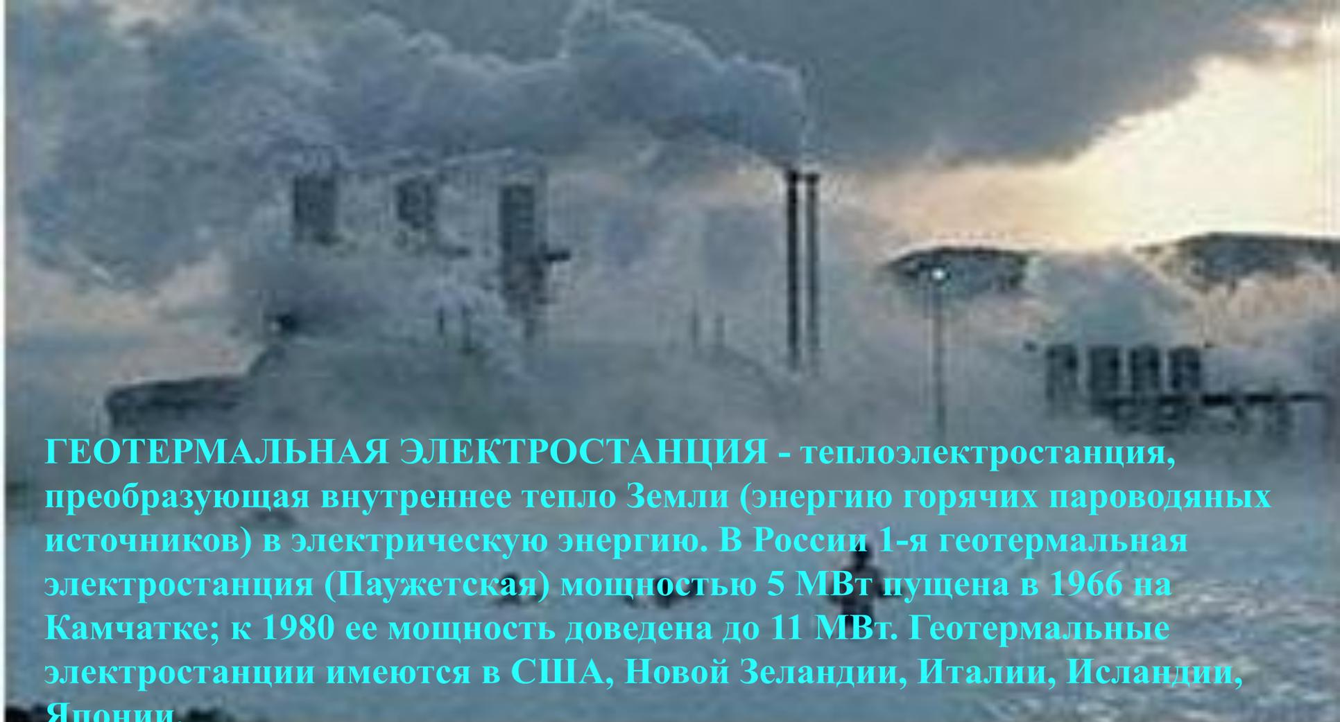
**ГЕОТЕРМАЛЬНАЯ ЭЛЕКТРОСТАНЦИЯ** - теплоэлектростанция, преобразующая внутреннее тепло Земли (энергию горячих пароводяных источников) в электрическую энергию. В России 1-я геотермальная электростанция (Паужетская) мощностью 5 МВт пущена в 1966 на Камчатке; к 1980 ее мощность доведена до 11 МВт. Геотермальные электростанции имеются в США, Новой Зеландии, Италии, Исландии, Японии.
