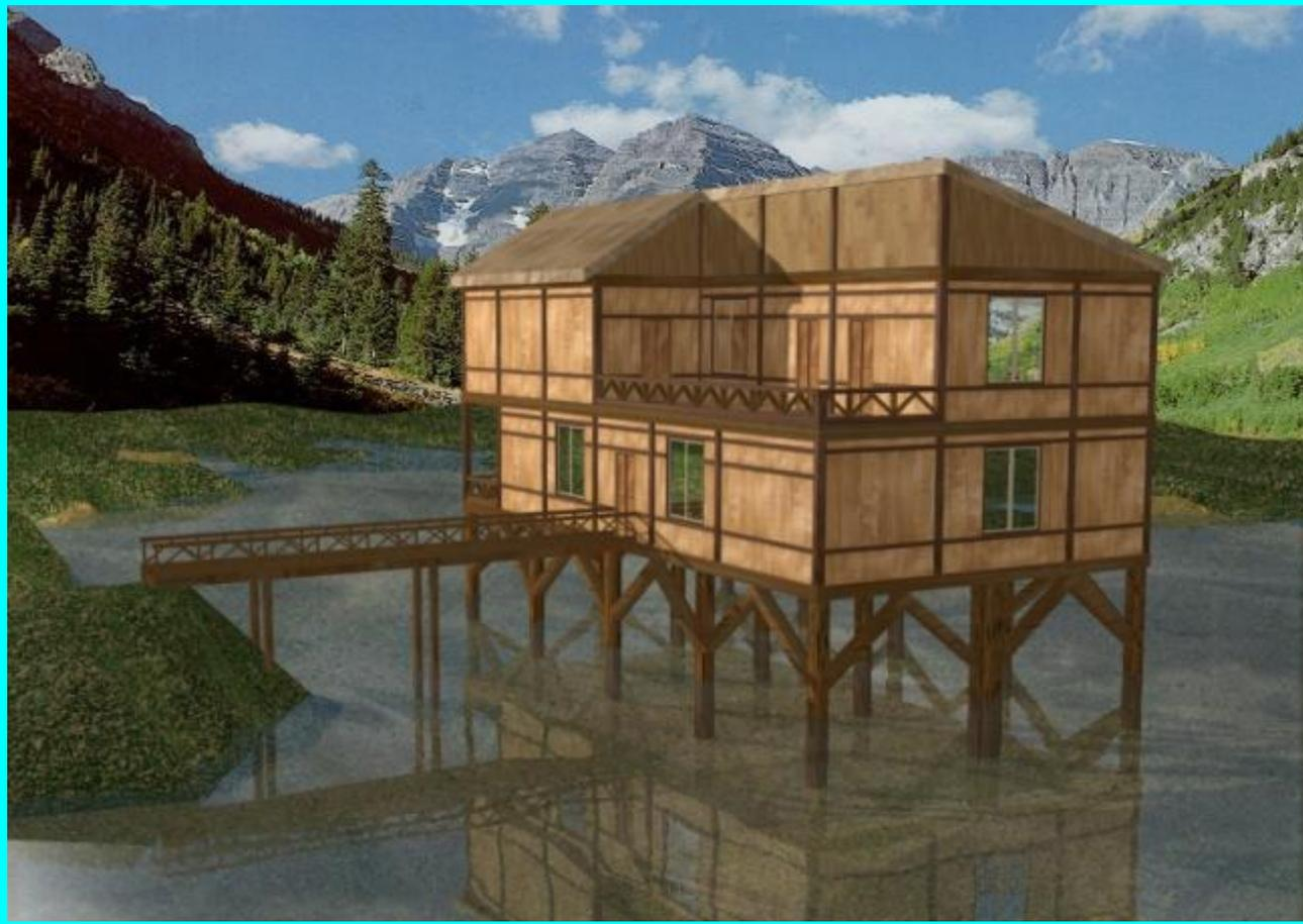
Их строят в жарких сырых местах. Двух — или трехметровые сваи, на которые водружают дома, обеспечивают помещению прохладу и сухость даже в сезон дождей или во время шторма. Стены делают из плетеных бамбуковых матов.
