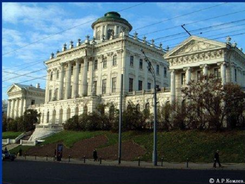
Дом Пашкова Архитектор Казаков
