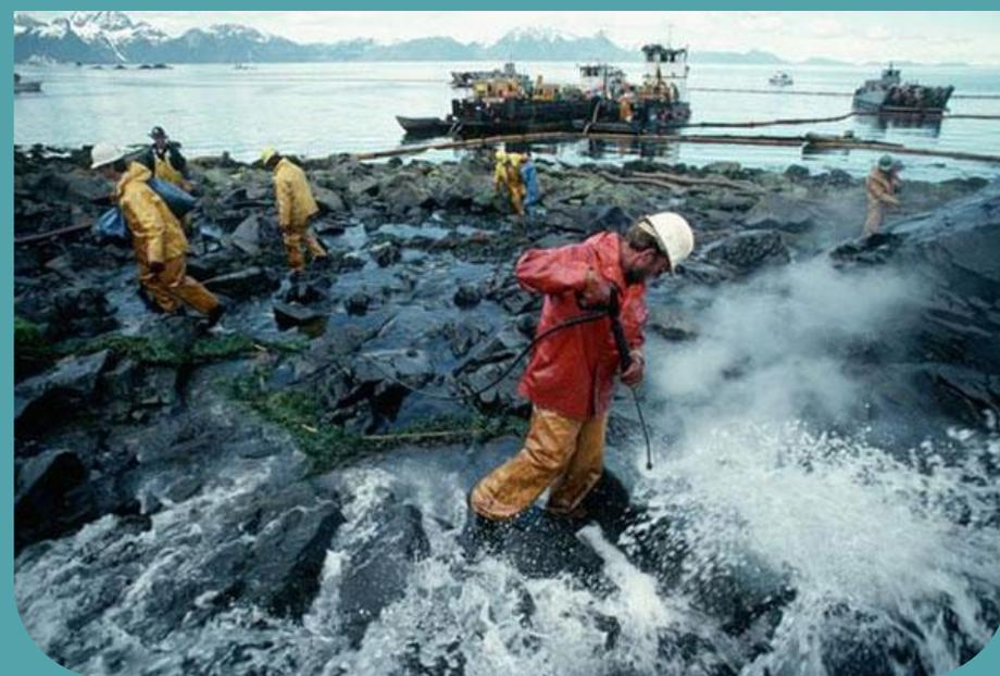
К механической очистке приступили сразу же после катастрофы, используя боны и скиммеры, но скиммеры не могли быть готовы раньше 24 часов, прошедших после аварии, толстый слой нефти, перемешанный с бурыми водорослями, засорял оборудование.
