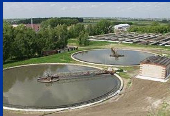
Вертикальный и радиальный отстойники
