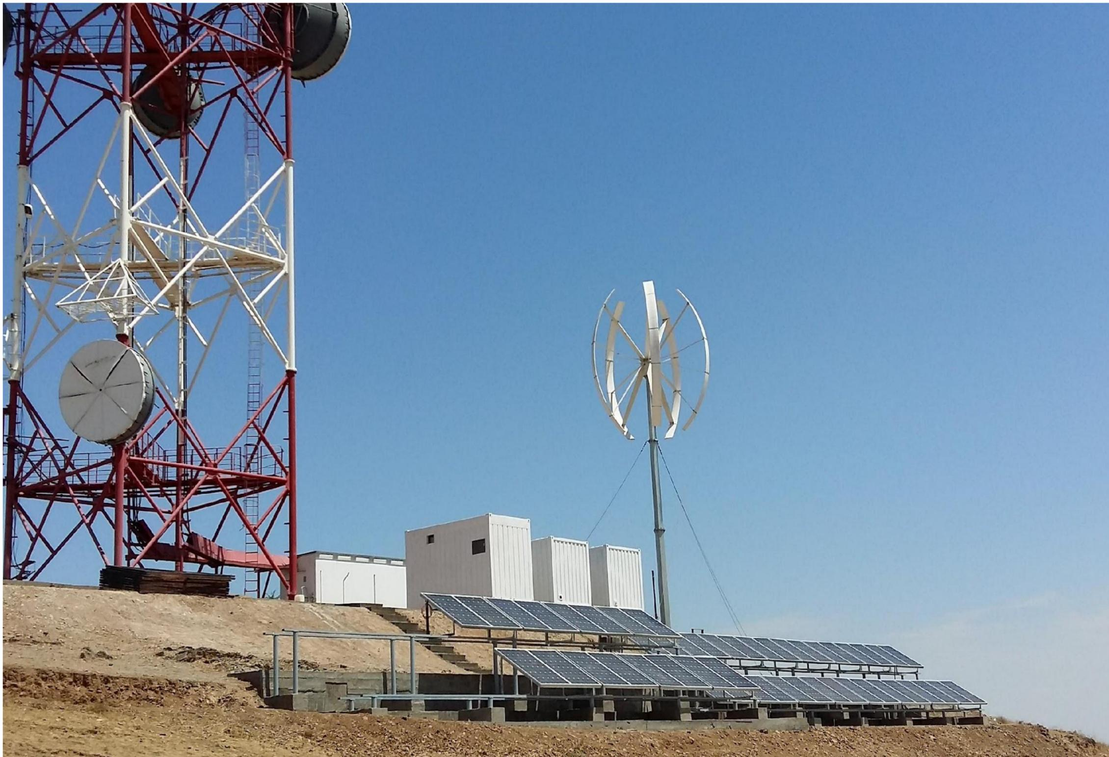
Рис. 6. Автономная солнечно-ветро-дизельная электростанция на объекте «Замбар».
