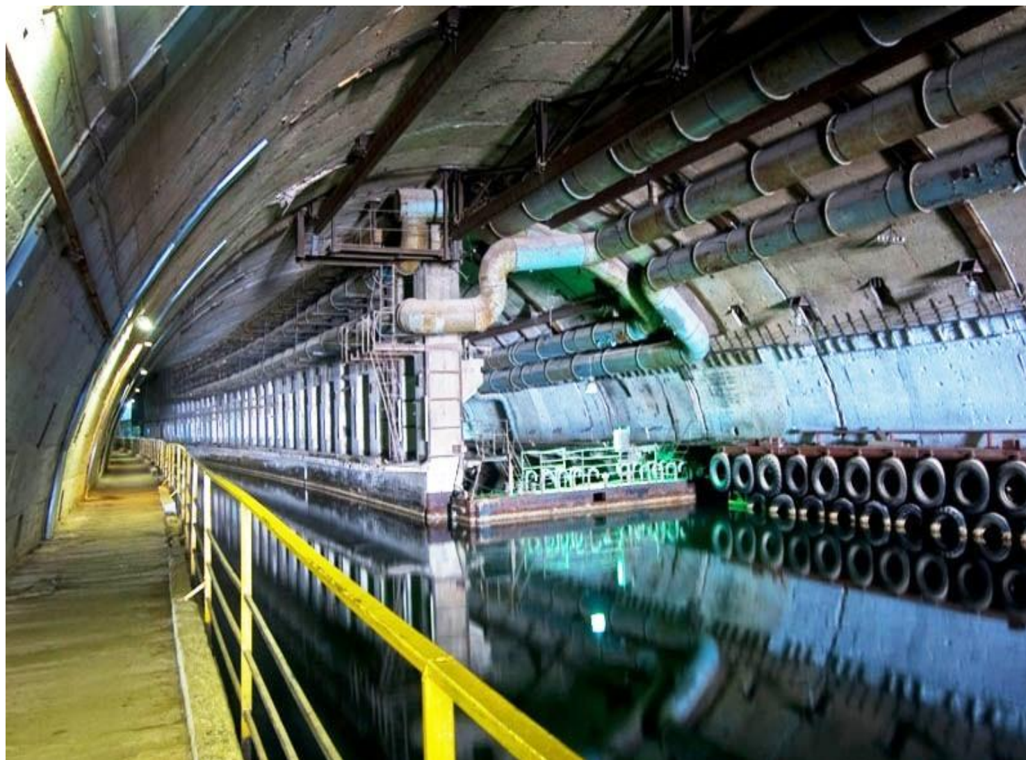
Вид канала внутри. Справа вход в док
