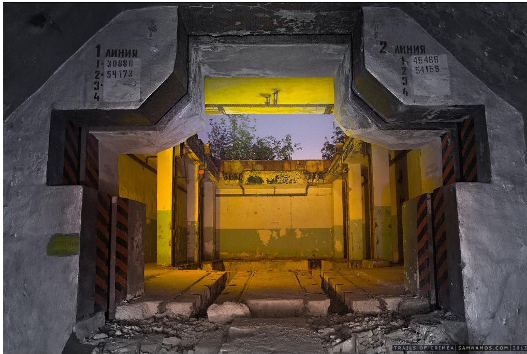
Вид в люк снизу до капитального ремонта
