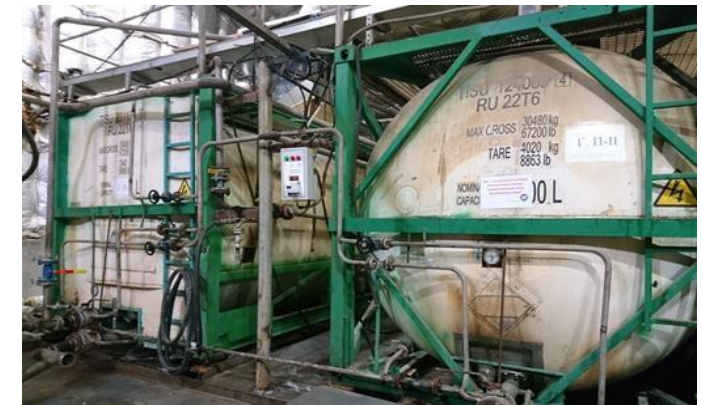
Буферная емкость с терморубашкой для подогрева готовой эмульсии
