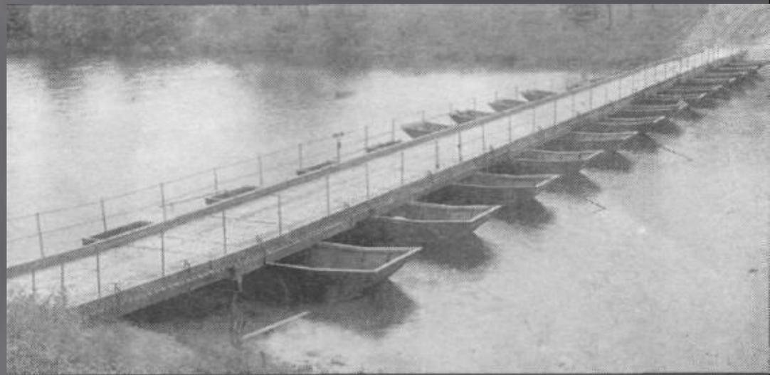
Наплавной мост из **легкого понтонно-мостового парка ЛЛП**
