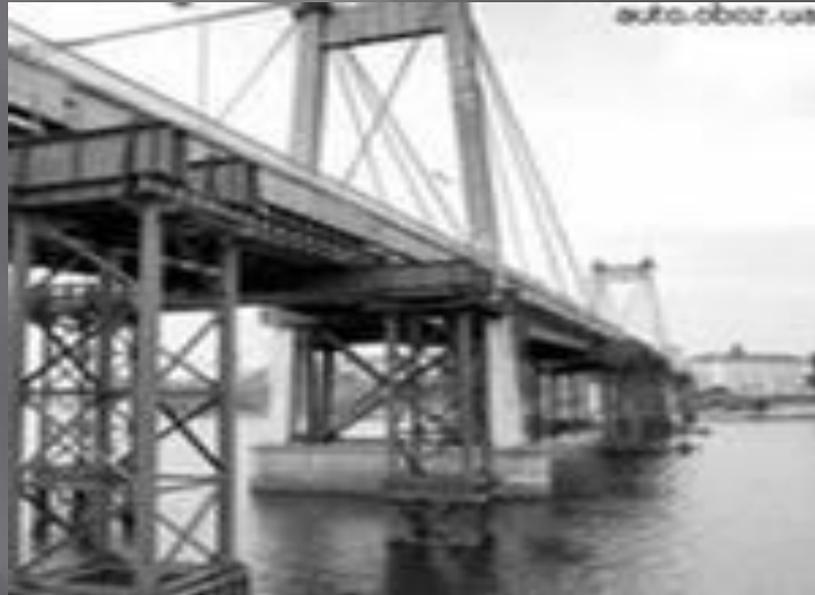
**Проезжая часть** создает удобную для езды поверхность, воспринимает на себя усилия от подвижных нагрузок и передает эти усилия на несущую часть.
