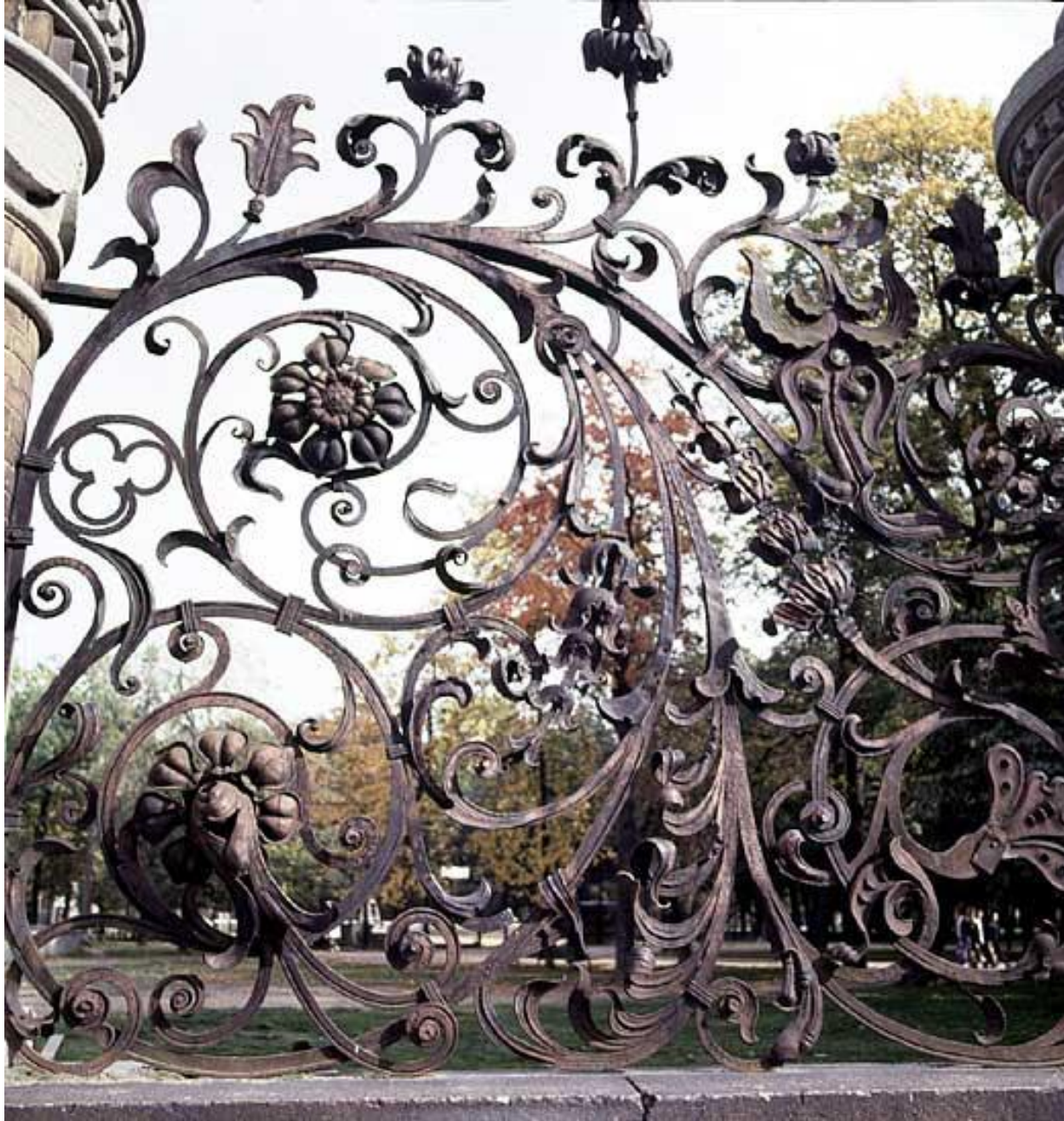
Ограда у собора Воскресенъя христова («Спаса на крови»). Арх. А. А. Парланд.
