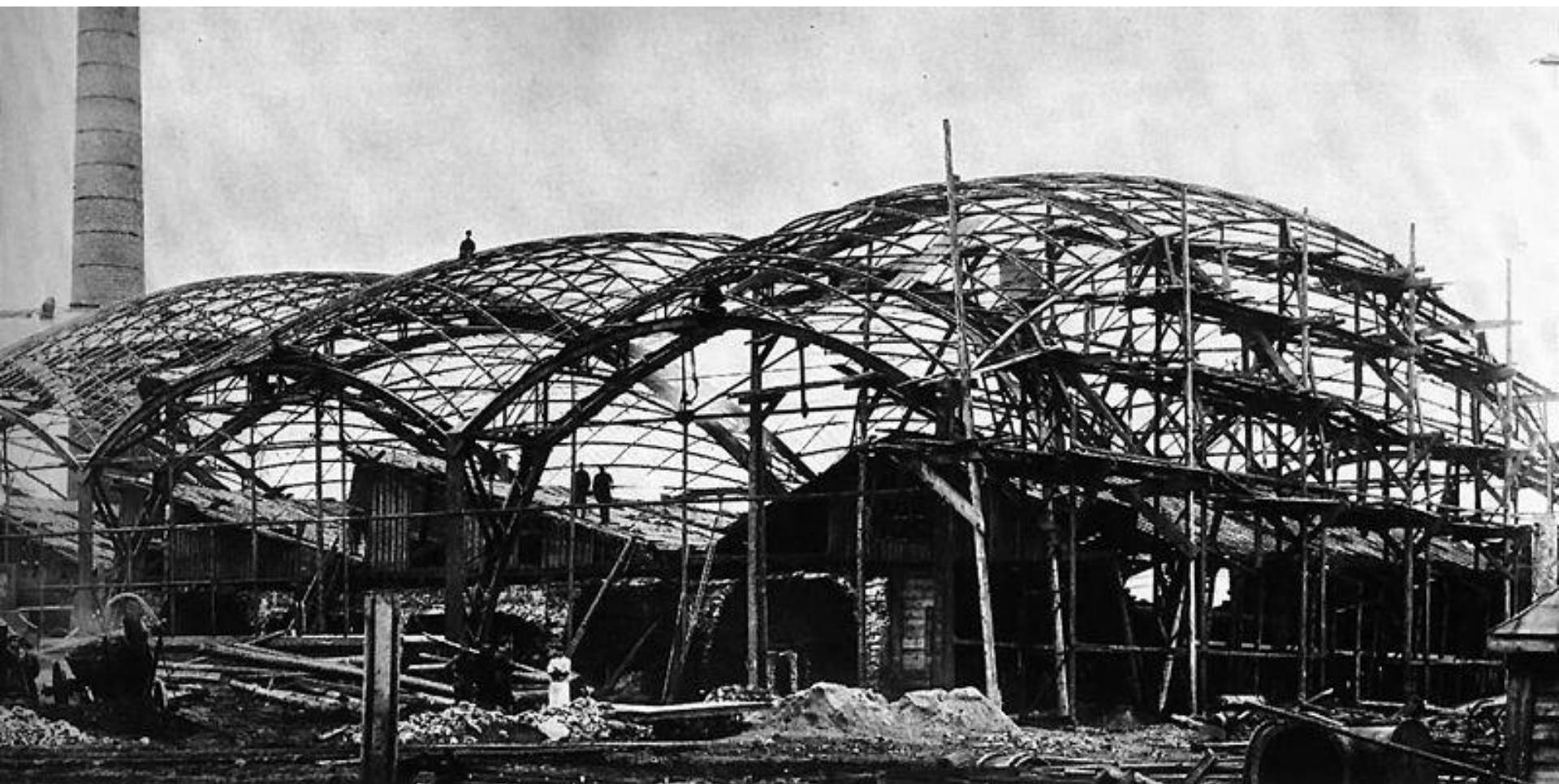
Оболочка – перекрытие двойкой кривизны конструкции В.Г. Шухова на Выксунском металлургическом заводе. Выкса. 1897 г.
