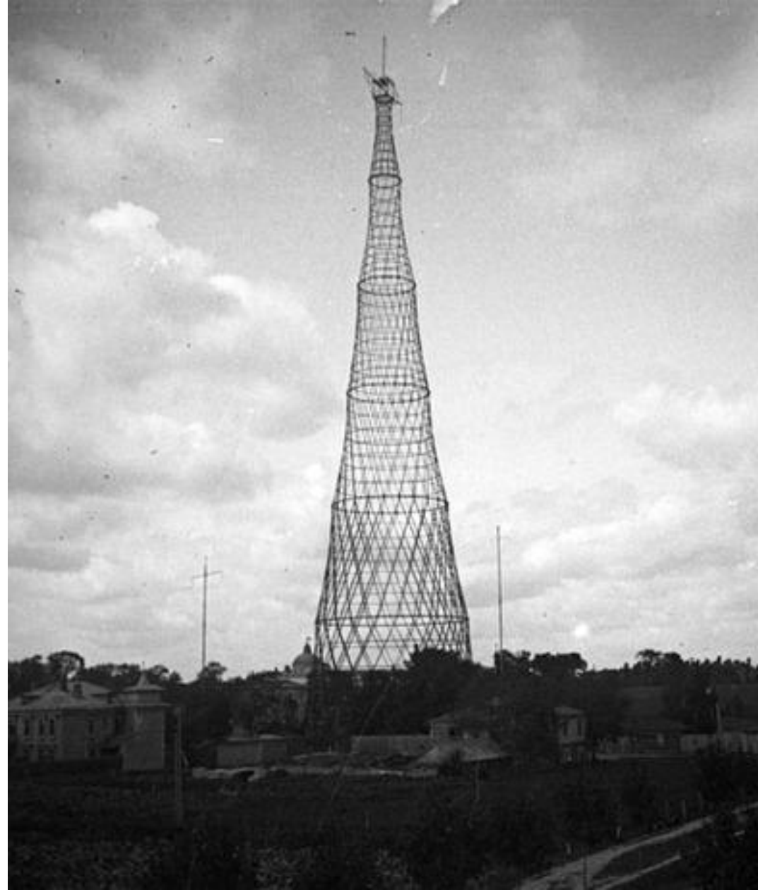
Башня В.Г. Шухова на Шаболовке в Москве. 1920 – 1922 г. Высота построенной башни – 160 м.
