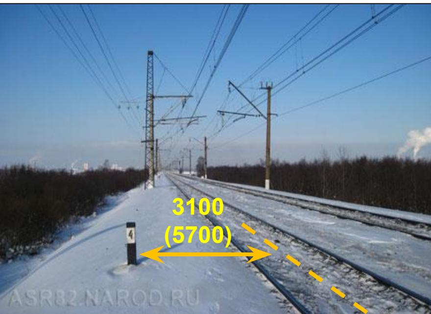
**путевой знак** - постоянный указатель профиля и протяженности железнодорожных линий; **устанавливается с правой стороны по счету километров**
