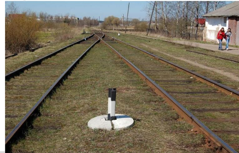
71. Предельные столбики указывают место, далее которого на железнодорожном пути нельзя устанавливать железнодорожный подвижной состав в направлении стрелочного перевода или глухого пересечения (рис. 153, 154). Предельные столбики у главных и приемо-отправочных железнодорожных путей должны иметь отличительную окраску (рис. 154).
