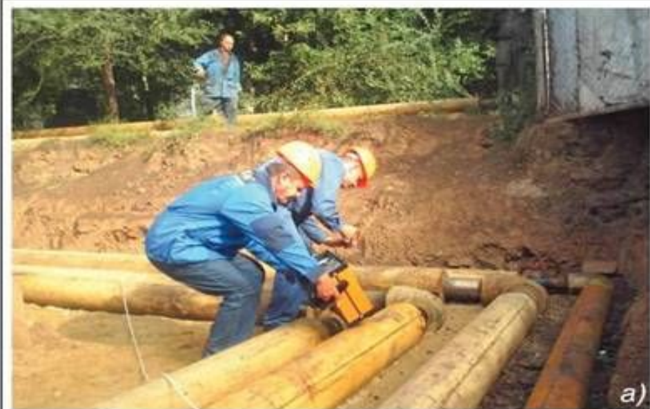
Рис. 2. Типы прокладок трубопроводов в ППМ изоляции: а – бесканальная прокладка; б – прокладка в непроходном канале; в – надземная прокладка.
