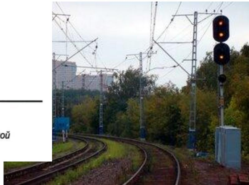
**Три желтых огня** - разрешается **одиночному локомотиву, МВПС и ССПС** следовать на свободный участок пути с особой осторожностью и со скоростью - **не более 20 км/ч, от начала пути приема до маршрутного светофора с красным огнем** (ИСИ, п.17)
