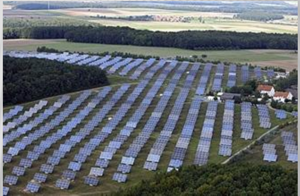
Солнечная электростанция в Германии
