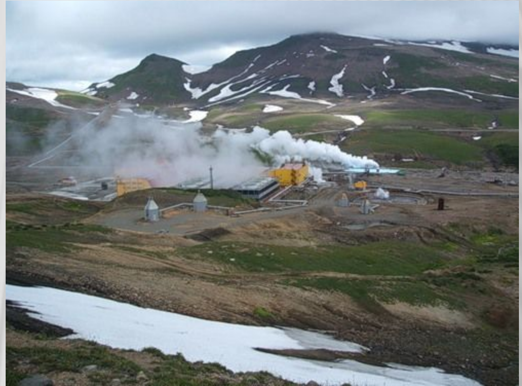
Мутновская геотермальная станция
