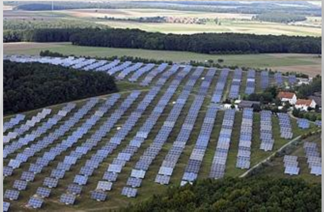
Солнечная электростанция в Германии
