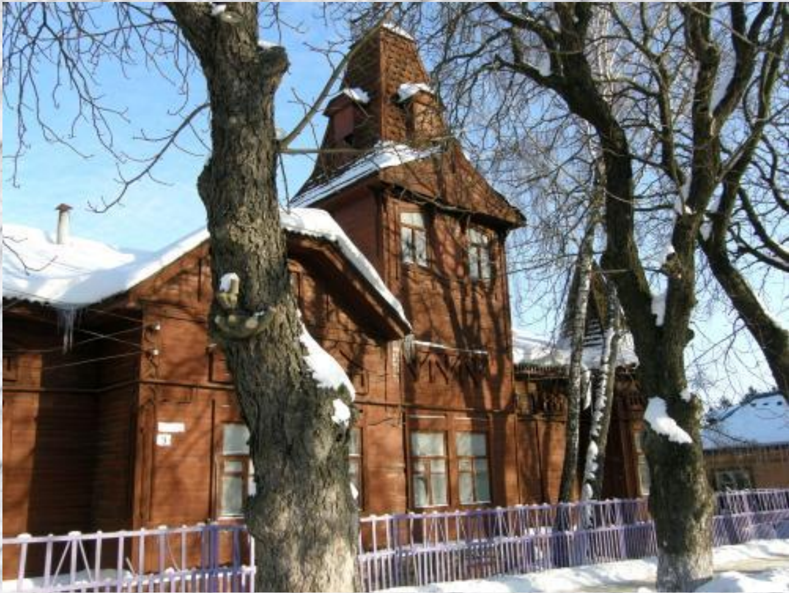
Будинок на вул. Павлова
