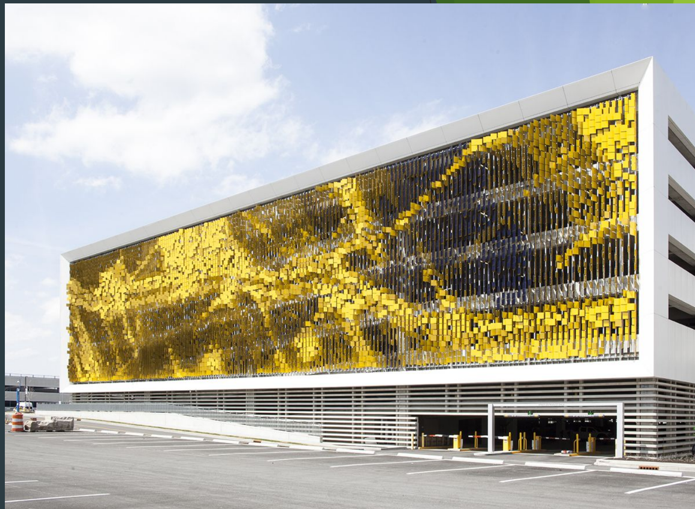
Eskenazi Hospital архитектора Роба Лея в Индианаполисе - удивительный пример того, как здание оживает, оставаясь при этом неподвижным.
