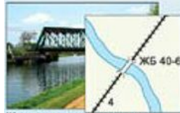
Железная дорога и железобетонный мост
