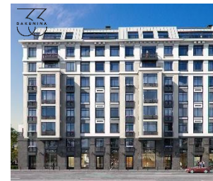
ЖК ВАКУНИНА 33 бизнес класс, 113 квартир Срок сдачи, 1 кв 2025 г.
