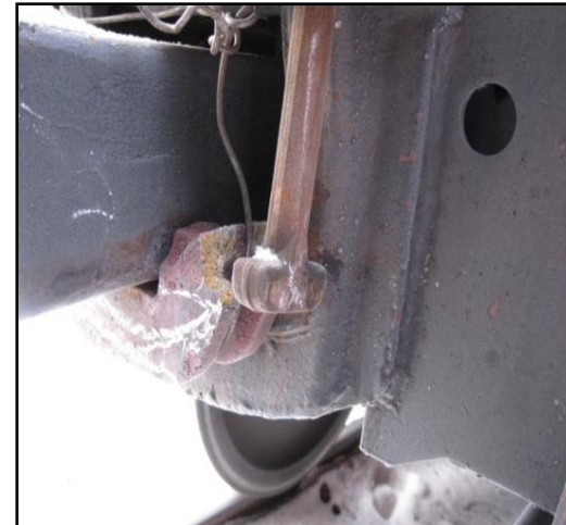
Излом центрирующей балочки
