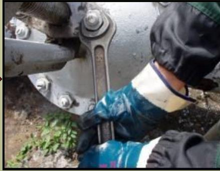
□ Подтянуть равномерно гайки крепления втулки сальника, не допуская ее перекоса.
