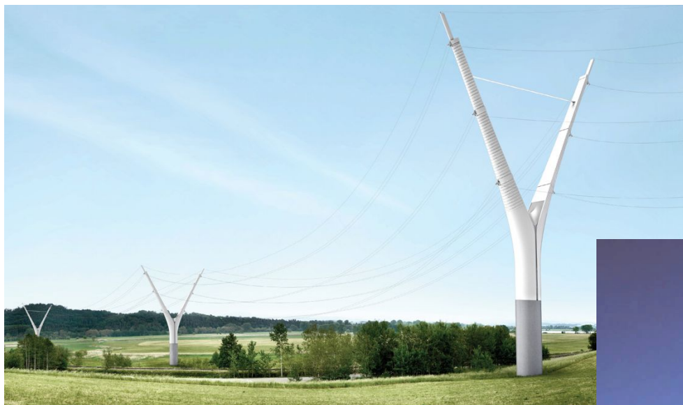
Проекты ЛЭП с опорами из композитных материалов
