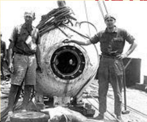
**Батисфера** (от греческого «батис» — глубоко и «сфера» — шар) — глубоководный аппарат в форме шара, опускаемый на тросе под воду с базового судна. В отличие от батискафа не является самоходным. Рекорд глубины, 932 метра, установленный 15 августа 1934 года Уильямом Биби (William Beebe) и Отисом Бартоном, продержался 15 лет. Максимальная глубина, достигнутая при помощи батисферы, составляет 1371,6 метров в 1948 году (пилот — Отис Бартон).
