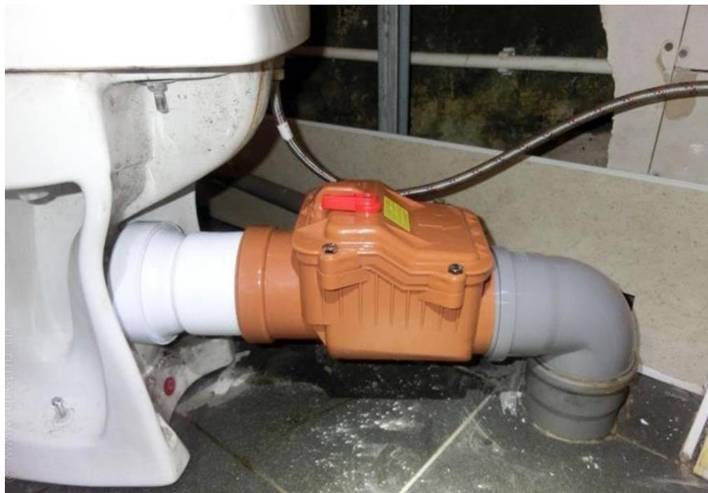
Обратный клапан представляет собой запорное устройство, блокирующее обратный ход канализационных стоков.
