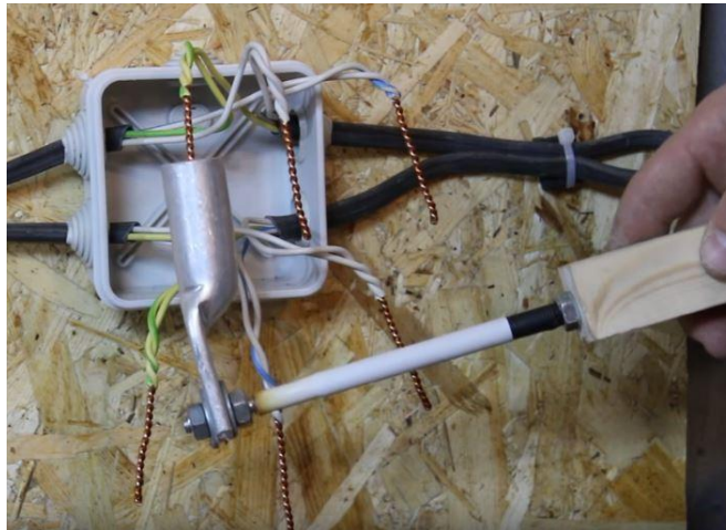
Расключение и пайка проводов в коробке
