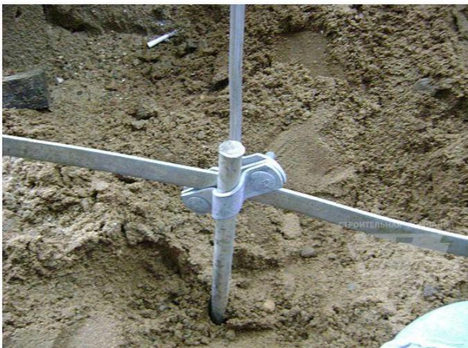
В проекте используются стержневые заземлители диаметром 12 мм и длиной 5 м и заземлители протяженные – полосовая сталь 40x4 мм в виде выравнивающей потенциал сетки, укладываемой на глубину 1 м
