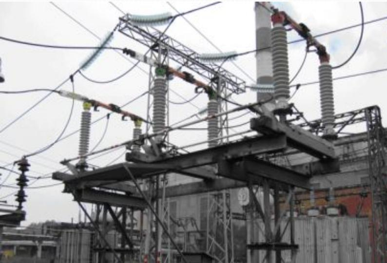
Из таблицы видно, что данный разъединитель удовлетворяет условиям выбора, следовательно, на РУ - 110 кВ принимаем к установке разъединители марки РНДЗ – 1-110/630Т1, данные разъединители имеют заземляющие ножи на одну фазу.
