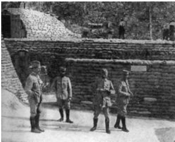
Французские оборонные сооружения, Сомма, 1916 г.
