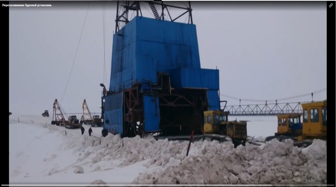
Перетаскивание буровой установки.
