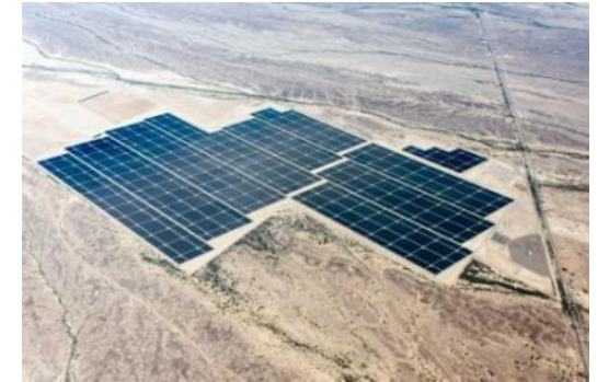
Солнечная электростанция Agua Caliente, Аризона США
