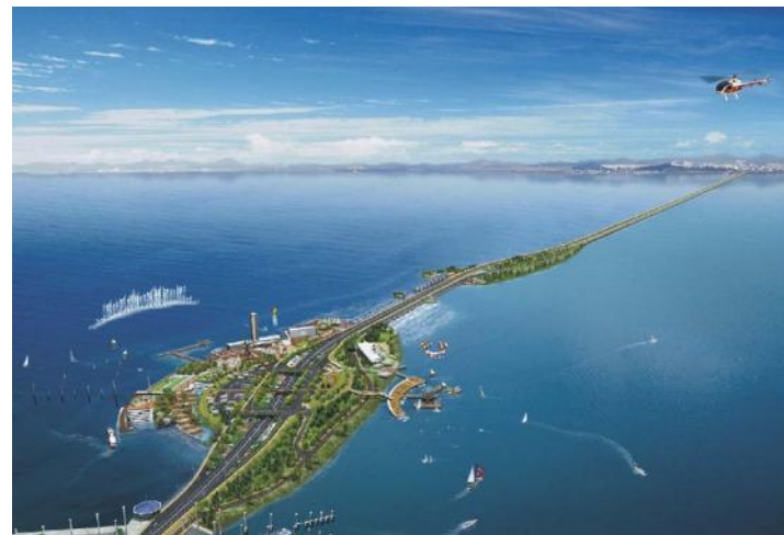
ПЭС Sihwa в Южной Корее
