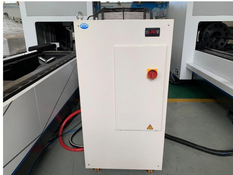
Функция кулера для воды состоит в том, чтобы снизить температуру лазерного генератора и предотвратить выгорание лазера. Мы используем только фирменные кулеры с надежным качеством.
