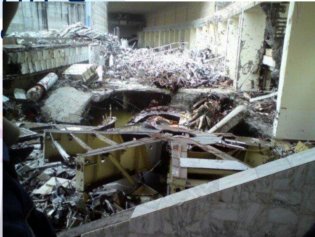
Машинный зал Саяно-Шушенской ГЭС после аварии
