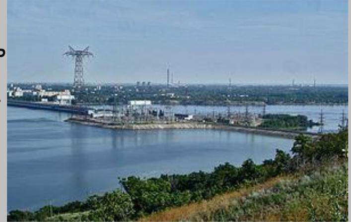
Саратовская ГЭС имеет три открытых распределительных устройства (ОРУ) напряжением 35, 220 и 500 кВ, связь между ними осуществляется через автотрансформаторы АОДЦТН-16 7000/500/220/35 (2 автотрансформатора по три отдельных фазы в каждом).
